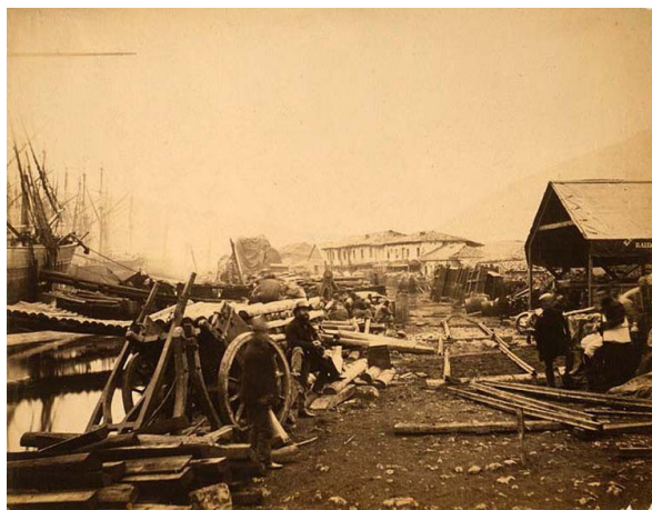
Строительство железной дороги в Балаклаве. Фото Р. Фентона, 1855 г.
